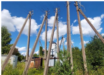
Attēls 24: Elektroapgādes infrastruktūra (apsekošana 30.07.2022.)
