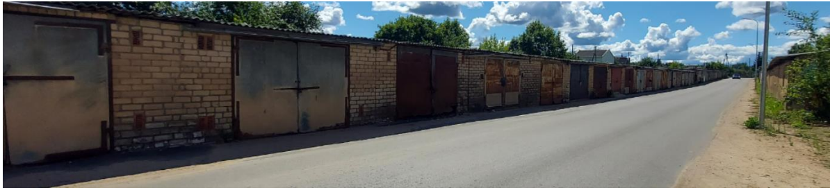
Attēls 10: Garāžas uz Centrālās ielas no Rēzeknes puses (teritorijas apsekošana 30.07.2022.)
